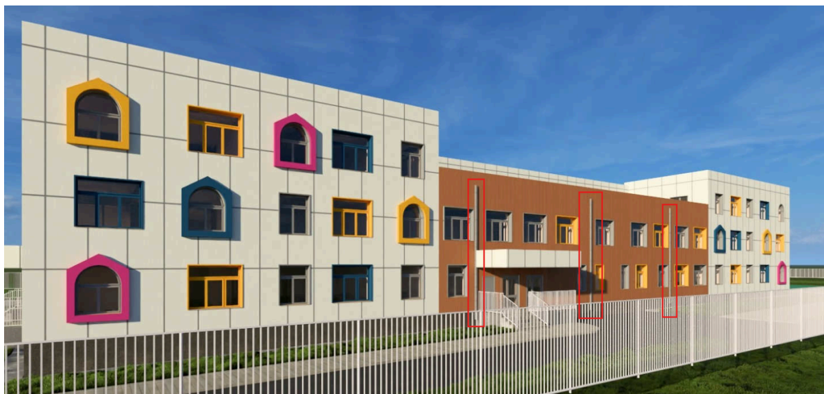
Рисунок 1. Водосточные трубы выделены красным цветом.
